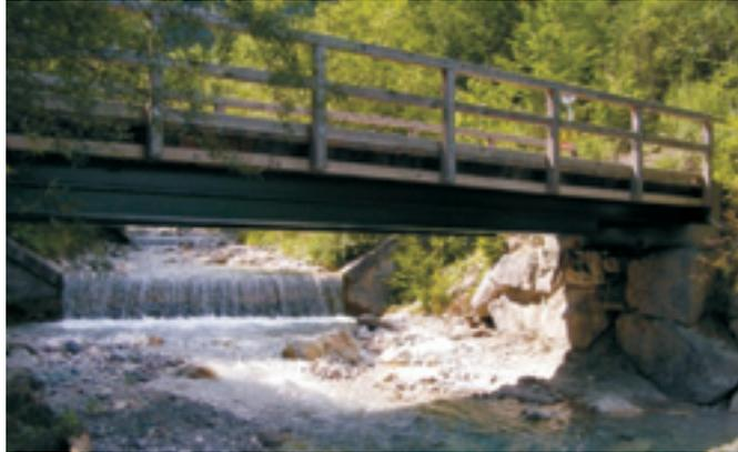
Auch die öffentliche Kollerbrücke in Rosenbach musste einer Generalsanierung unterzogen werden. Um den starken Belastungen standzuhalten, wurde die Stahlkonstruktion mit zusätzlichen Trägern verstärkt und anschließend sandgestrahlt und lackiert. Die Gesamtkosten für
